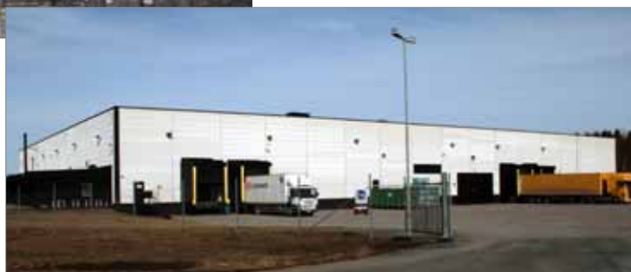
Sweden Trade AB, Bro. 6.500 m 2 logistikfastighet med lager och kontor.
